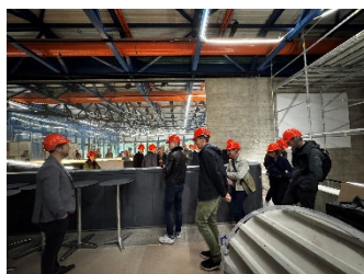
Offen geführte Haustechnik, welche auch für die neuen Leitungen beibehalten wurde.
